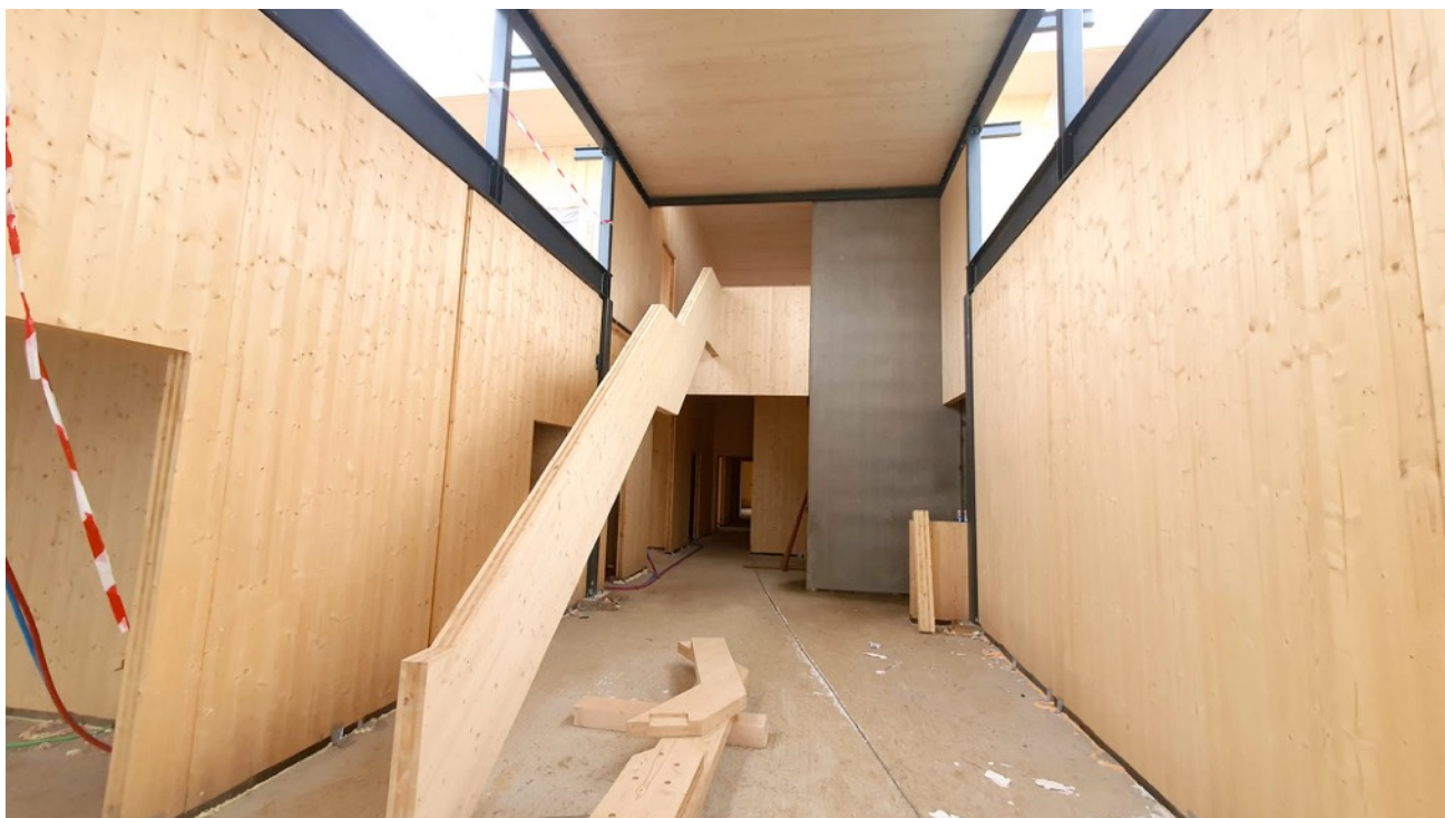
Hall d'entrée ( Futur escalier à gauche et cage d'ascenseur au fond)
